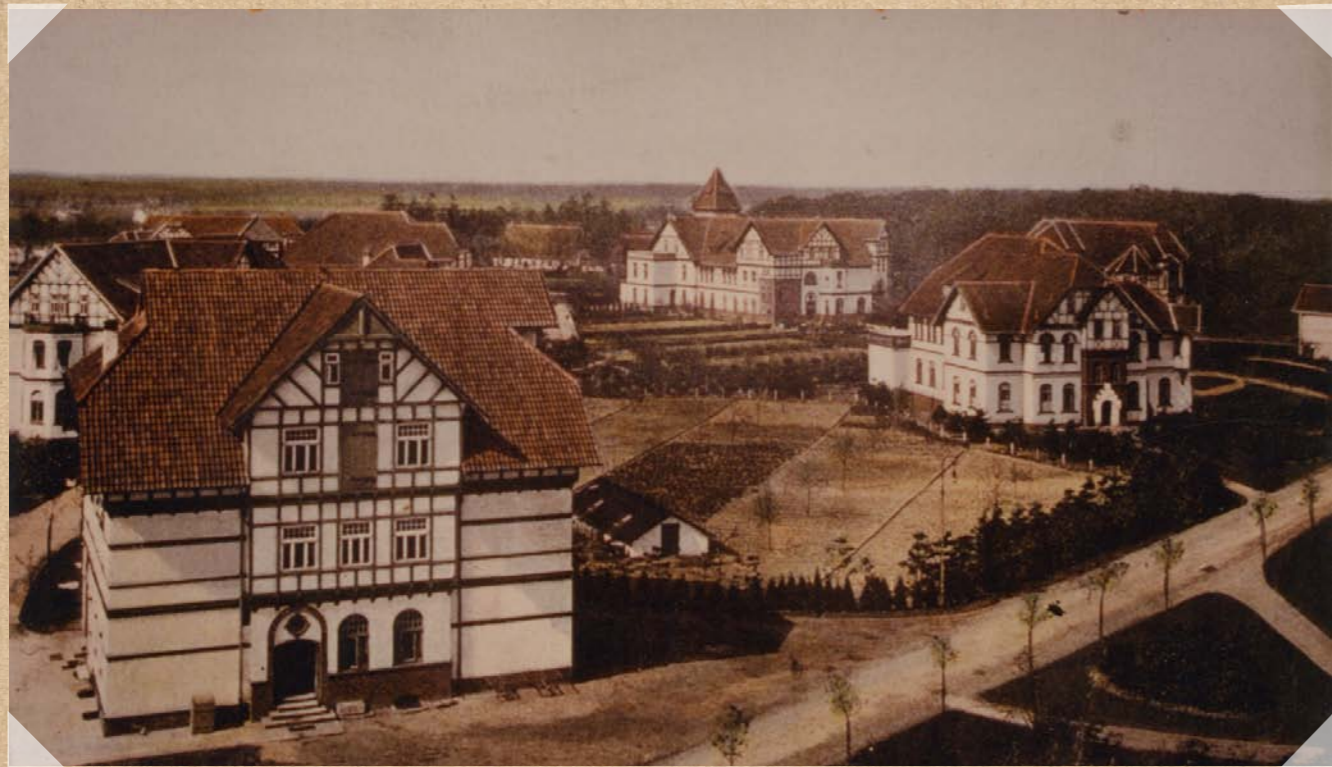
Das Park- und Gebäudeensemble des 1904 eröffneten „St. Jürgen-Asyls für Geistes- und Nervenranke“ wurde 2004 als überregional bedeutsames Kulturdenkmal unter Schutz gestellt.
